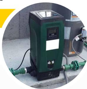
Completo di tutte le interfacce necessarie per la connessione all'impianto e di piedini antivibranti. Grazie alle 4 possibilità di configurazione idraulica l'installazione diventa ancora più rapida e flessibile. In caso di manutenzione e.sydock consente la portabilità di e.sybox grazie alla funzione di disconnessione rapida, evitando di lavorare sull'impianto.
