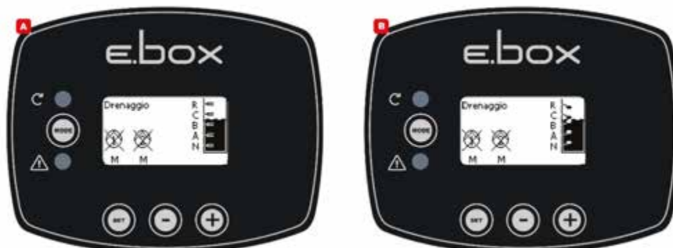
Figura 37: Stare sistem in modalitate drenaj, A cu sonde de nivel. B cu plutitori
